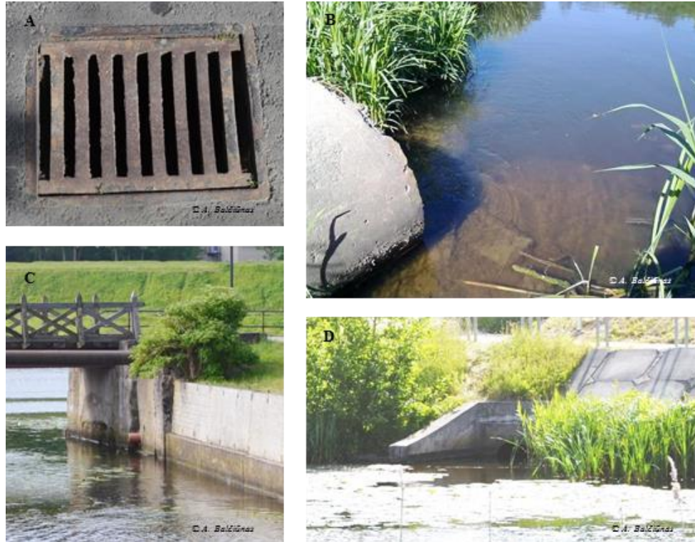
2.5.2 pav. Paviršinių nuotekų sistemos elementai Klaipėdos mieste: A- Lietaus nuotekų įlaja , B – išleistuvas ties Luizės mikrorajonu , C – išleistuvas ties Jono kalneliu , D – išleistuvas ties Liepų g. tiltu .
